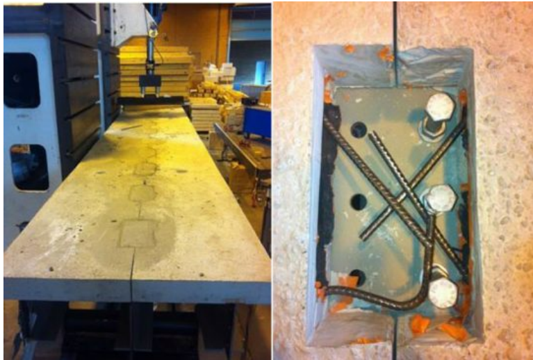
© MECD - Le plancher mixte acier béton et sa réservation pour la connexion
